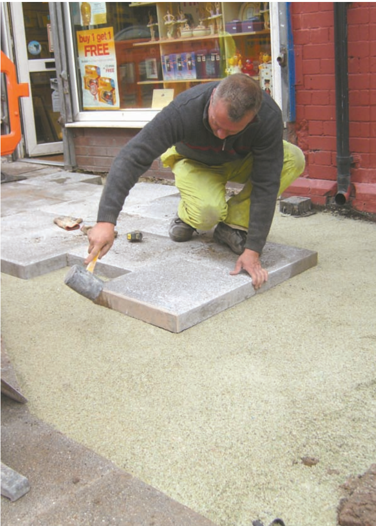
Nid tywod sy’n cael ei ddefnyddio wrth osod cerrig palmant ond gwydr poteli ailgylchedig wedi’u malu’n fân.
